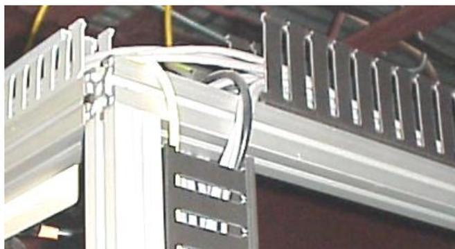
Abb. 24: Kabelkanäle
