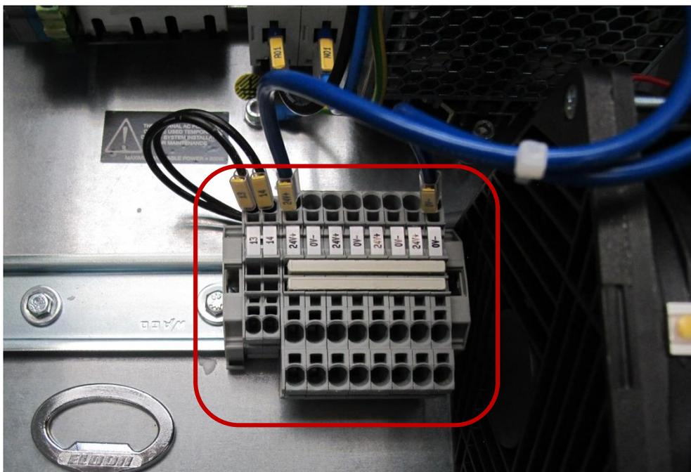
Abb. 5 – PWR-480B 24VDC-Anschlüsse
