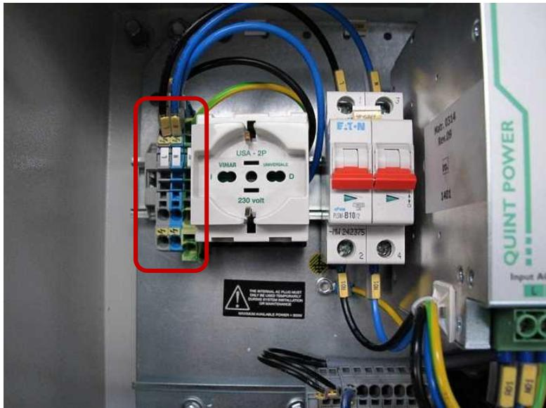
Abb. 4 – PWR-480B Netz-Anschlüsse
